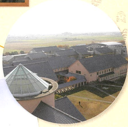
えんぴつ塔から見た 共通講義棟 (A棟) ↓
