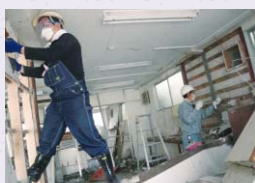
▲浸水家屋の壁面取り壊し作業をする玉井さん(左)
